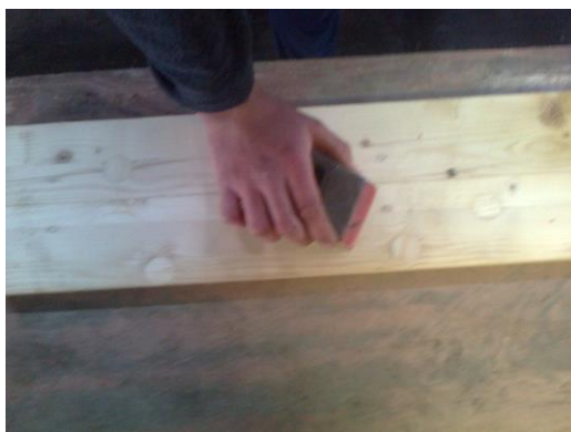
Obr. Úprava pomocí smirkového papíru
