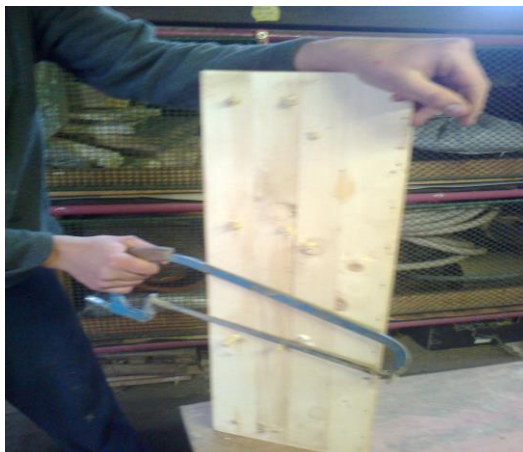
Obr. Uříznutí přesahujících tyček
