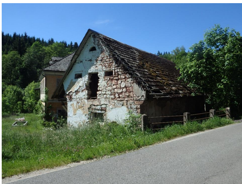
Obrázek č. 56: Bližší pohled na stáje (Zdroj: autor)
