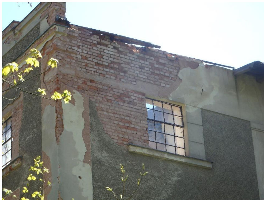
Obrázek č. 6: Detail chybějící střechy (Zdroj: autor)
