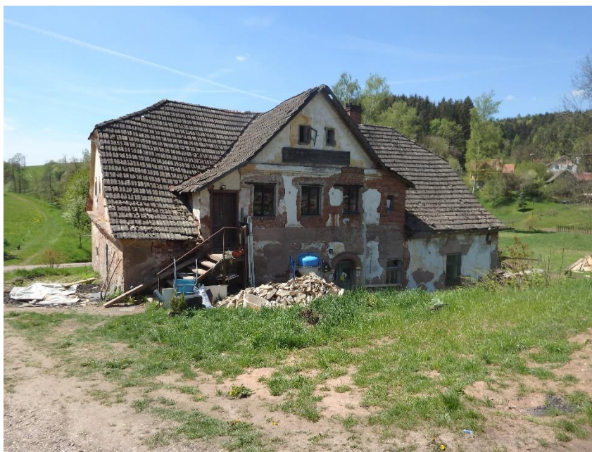
Obrázek č. 24: Pohled na celou budovu (Zdroj: autor)
