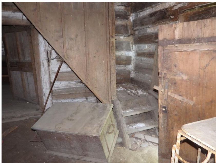
Obrázek č. 42: Schody do podkroví (Zdroj: autor)
