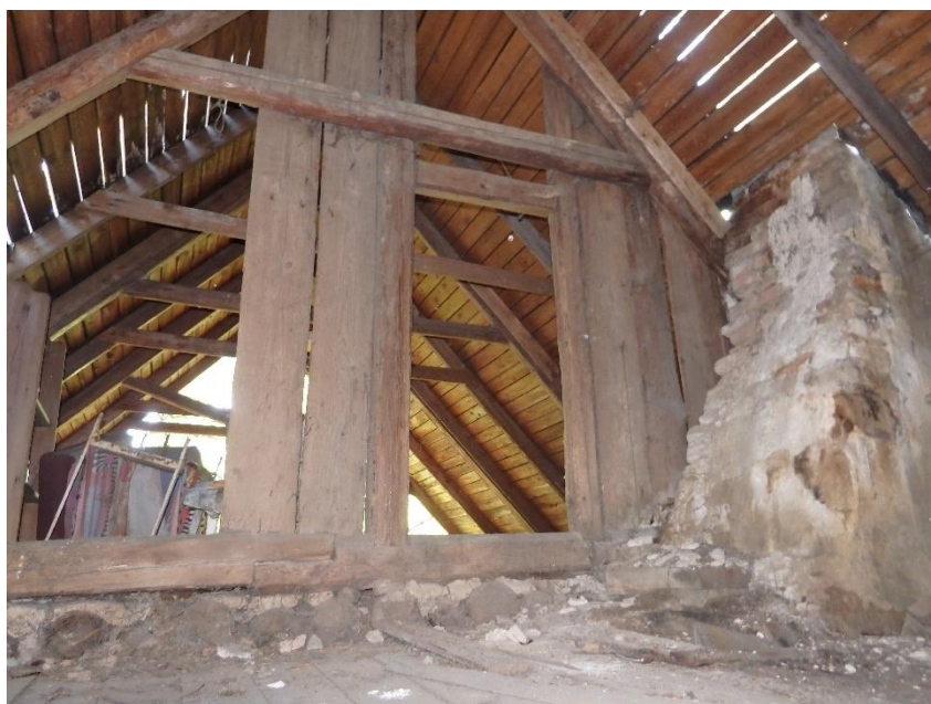
Obrázek č. 43: Podkroví roubenky se střechem a komínem (vpravo) táhnoucím se od kamen ve světnici (Zdroj: autor)
