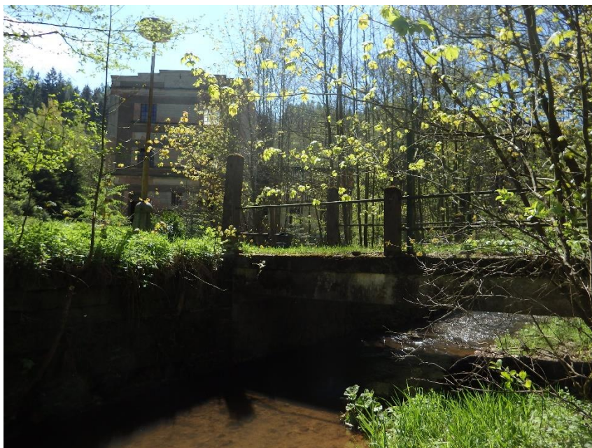
Obrázek č. 10: Most s příjezdovou cestou, pod níž protéká řeka Javorka s částečně dochovaným jalovým žlabem (Zdroj: autor)
