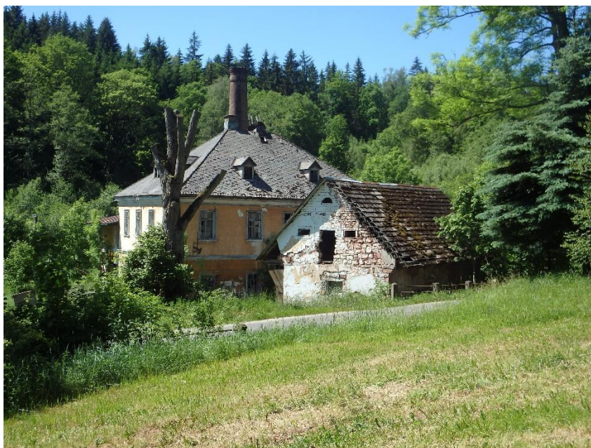
Obrázek č. 47: Pohled na celou usedlost (Zdroj: autor)
