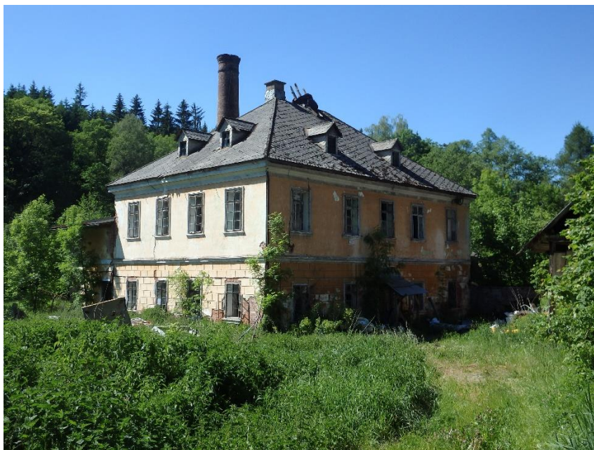
Obrázek č. 48: Detailnější pohled na mlýn (Zdroj: autor)
