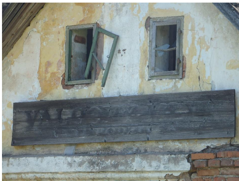
Obrázek č. 28: Zašlý nápis „VÁLCOVÝ MLÝN“ na průčelí domu (Zdroj: autor)
