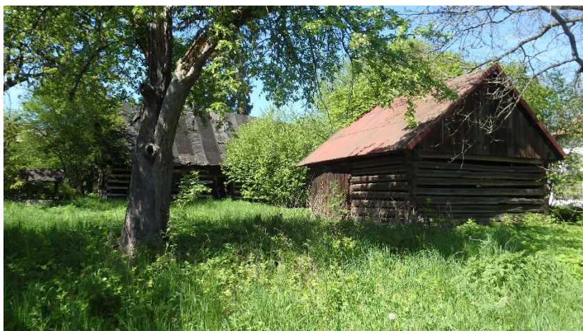
Obrázek č. 30: Pohled na celou usedlost (Zdroj: autor)
