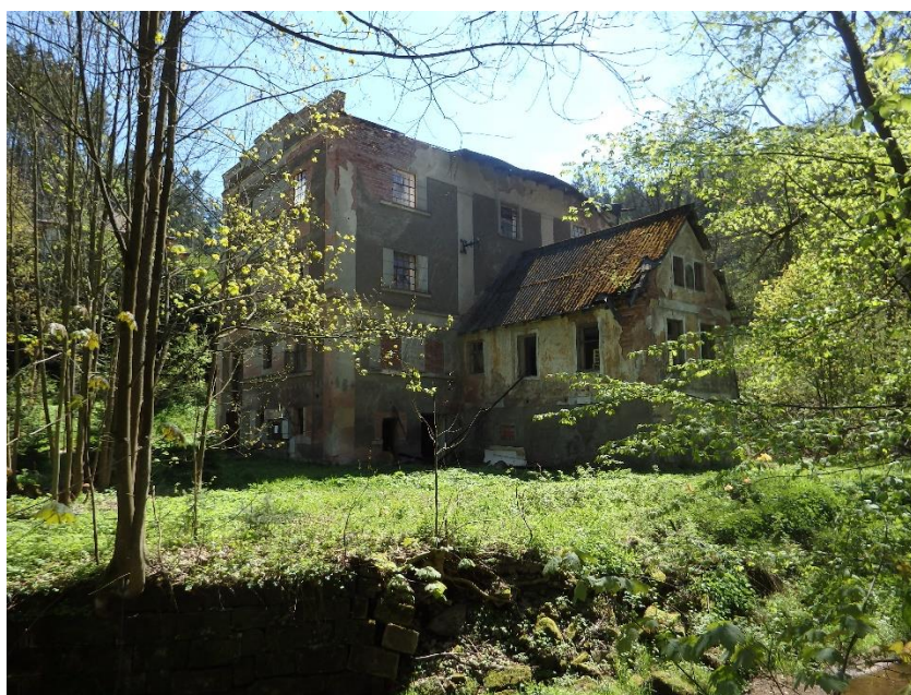
Obrázek č. 1: Pohled na celou budovu (Zdroj: autor)
