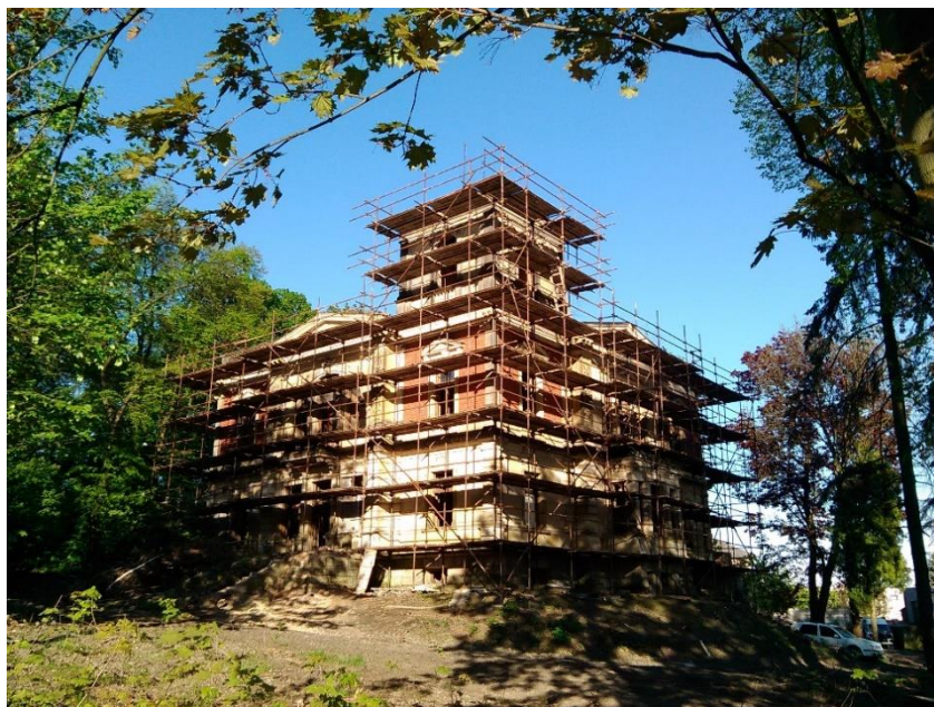
Obrázek č. 18: Vila během začátku rekonstrukce, březen 2017 (Zdroj: Michal Ludvík)
