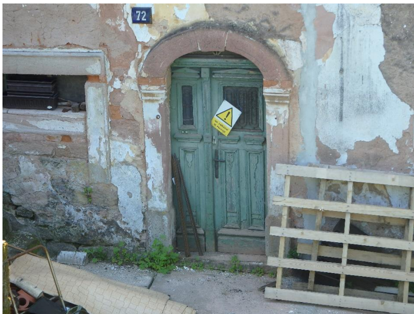
Obrázek č. 29: Číslo popisné nad původními dveřmi domu (Zdroj: autor)
