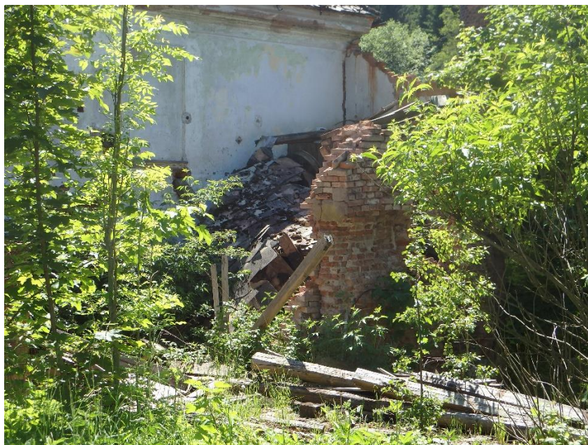
Obrázek č. 53: Zborcená východní část mlýna (Zdroj: autor)
