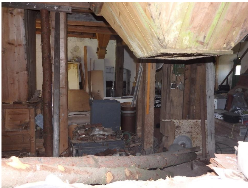
Obrázek č. 27: Vnitřek budovy se zřetelnými pozůstatky původního vybavení mlýna, násypka (Zdroj: autor)
