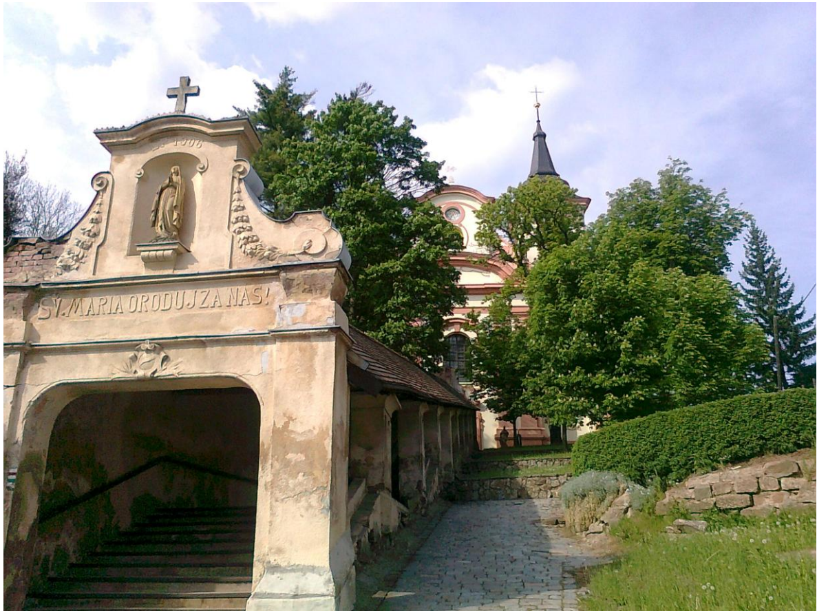
Obrázek 1: Kryté schody, přibyli ke klášteru v roce 1735
